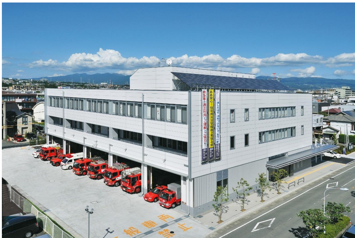
駿東伊豆消防本部（沼津市）
