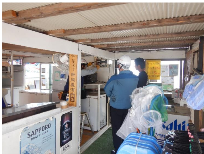
電気配線等の確認
