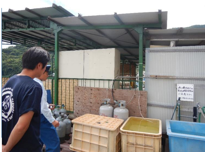
ガスボンベの固定状況の確認
